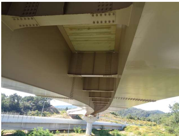
교량 바닥판 전경
