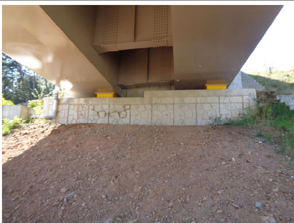
교량 하부 전경
