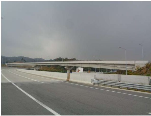
교량 측면 전경
