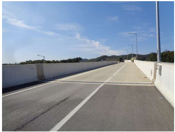
교량 상부 전경
