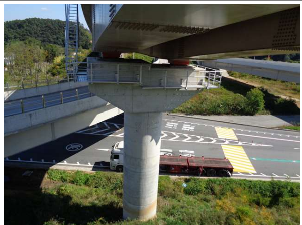
교량 하부 전경
