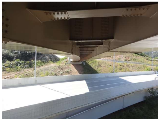
교량 거더 전경
